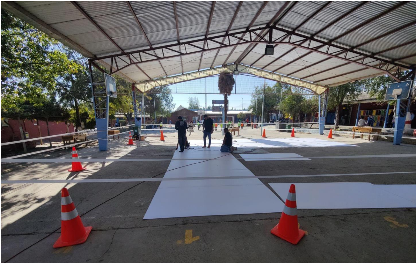
Instalación de plataformas en Escuela Hijos del Sol, Mostazal.
