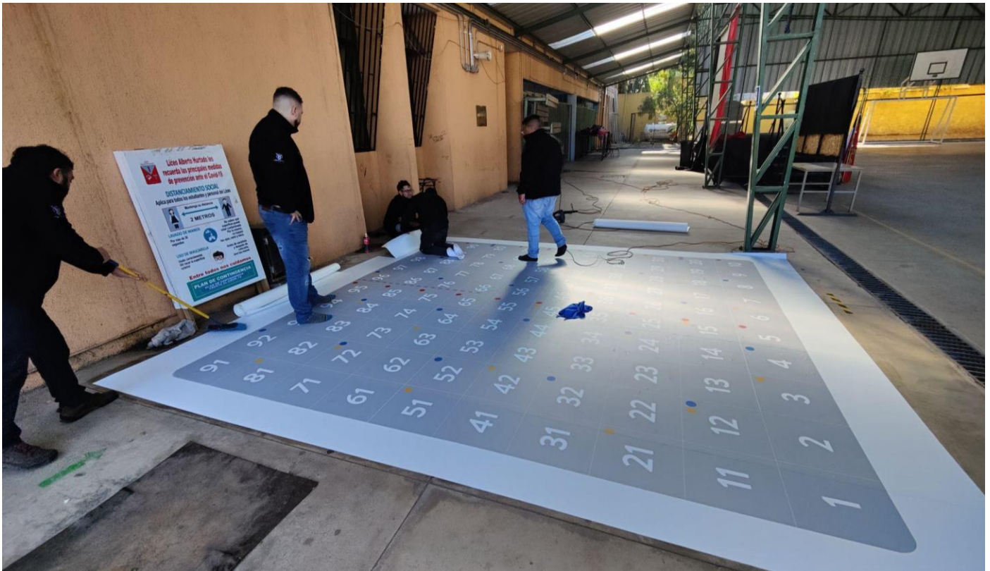
Instalación de plataformas en Colegio Andrés Bello, Mostazal.
