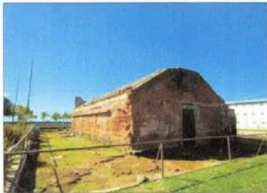
Casa de Pólvora.
