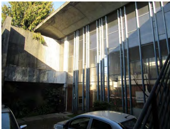
Estacionamiento con acceso inclusivo
