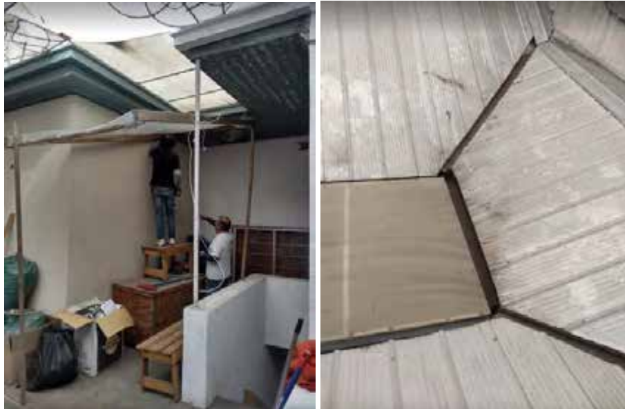
Figura 08 y 09. Limpieza de techos y arreglos en baladas de aguas lluvias en depósito y archivo. Fuente. AVJ. 2023.
