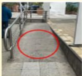
Arreglos de bajada a costado del CEM
