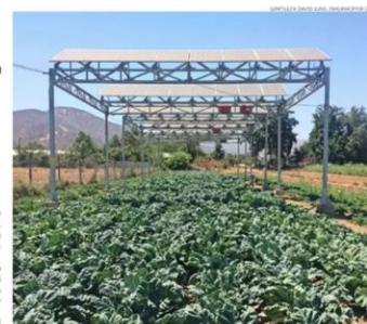
Los paneles son colocados a una altura y posición que permiten el paso necesario de luz solar al cultivo e incluso el uso de maquinarias.
