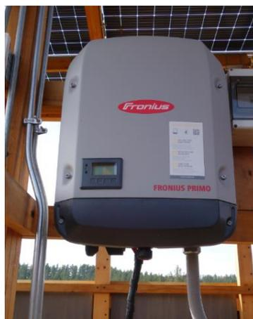
Figura 18- Inversor Fronius instalado en Torre Peñuelas
