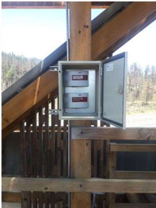
Figura 24 - Tablero eléctrico para los sensores BOX
