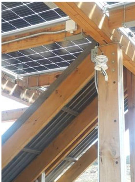
Figura 22 - 2 Sensores de temperatura ambiental
