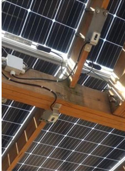
*Figura 19 - Celdas de Referencia traseras*
