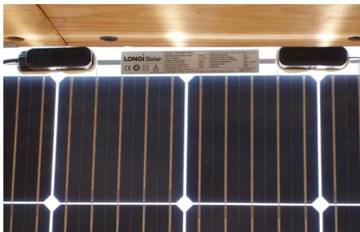
Figura 16 - Módulo PV bifacial instalado en Torre Peñuelas
