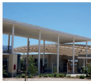
COLEGIO TRIGALES DEL MAIPO BAJOS DE MENA / PUENTE ALTO
