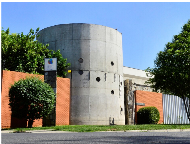
Instalaciones Centro de Diagnóstico MATER 2025
