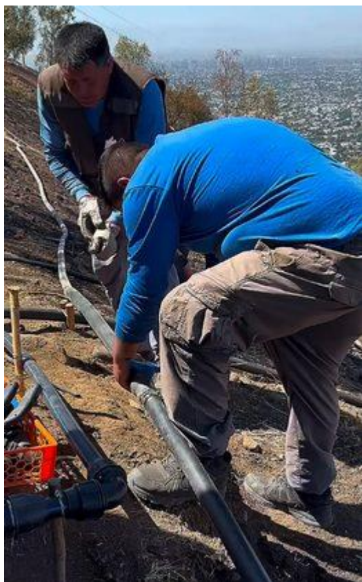
Reparación de líneas de riego post-incendio
