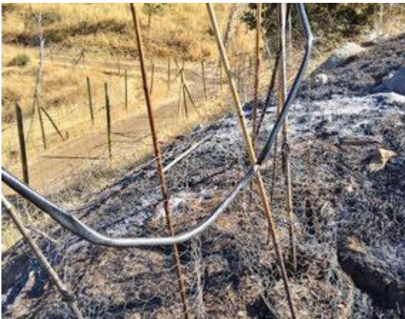
Mallas y líneas de riego quemadas
