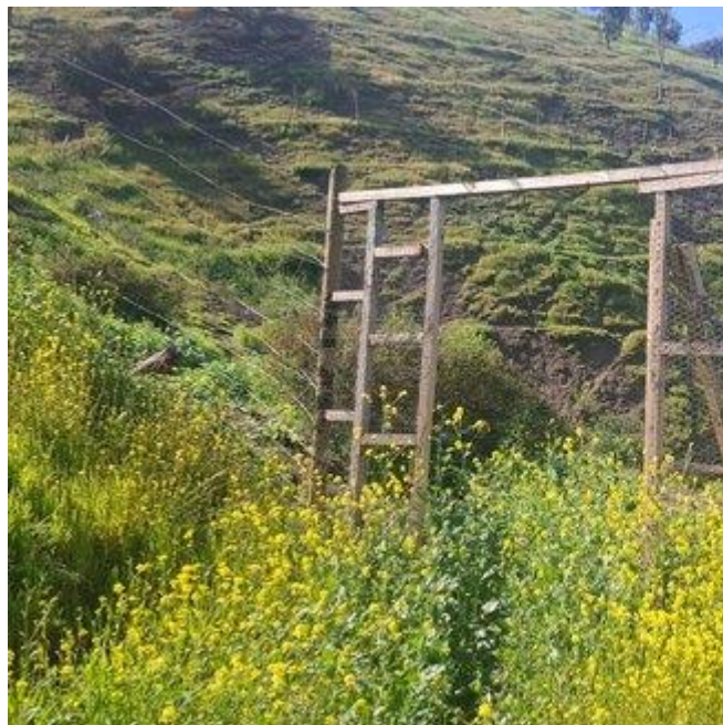
Malla perimetral de protección
